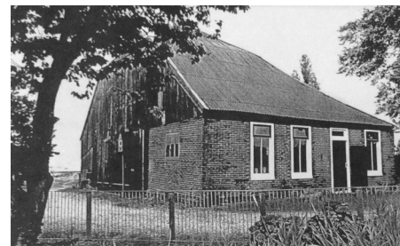
Oorspronkelijke (inmiddels gesloopte) boerderij Engewormer 20. BOERDERIJSTICHTING
