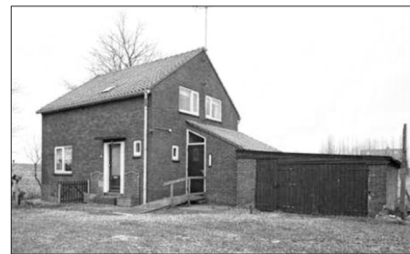
Woonhuis Engewormer 20, gebouwd door de familie Kramer. DE WORMERLANDER
