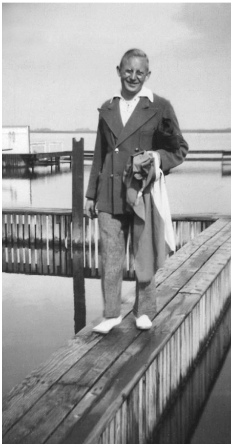
Verzetsman-badmeester Jan Kuijper repareerde, verkleed als monteur van Klinkenberg, de brug. WATERLANDS ARCHIEF
