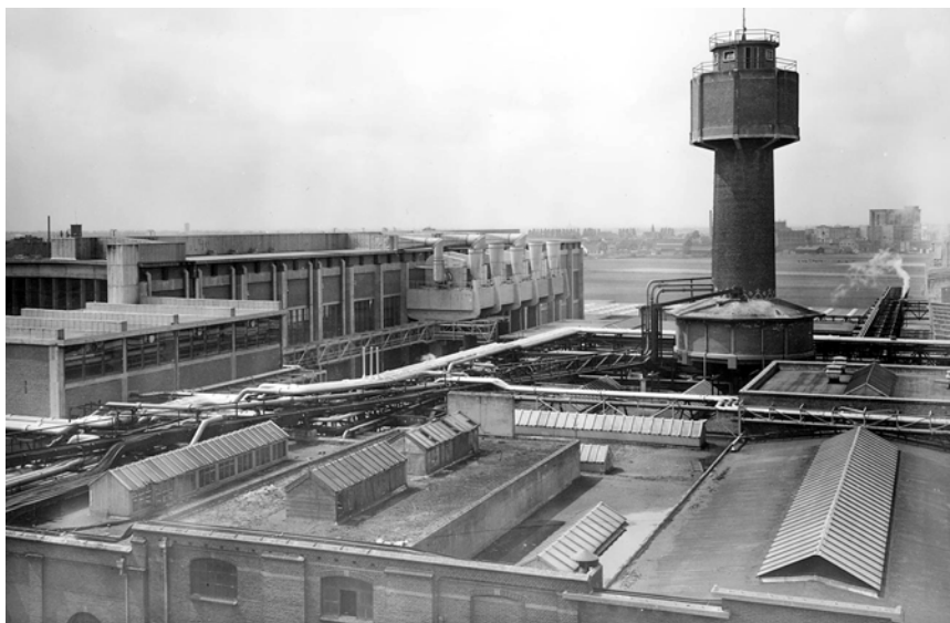
Een deel van het Van Gelder-complex compleet met de watertoren. De foto komt uit de collectie van Vereniging tot Behoud van Monumenten van Bedrijf en Techniek Zaanstreek (MBTZ). Links onderaan is het begin van de pijpenbrug over de Westerveersloot te zien. Over deze pijpenbrug liepen onder andere de stoom- en waterleidingen vanuit het ketelhuis naar de diverse papiermachines. Een gedeelte van deze leidingen liep rechtstreeks naar de watertoren.
