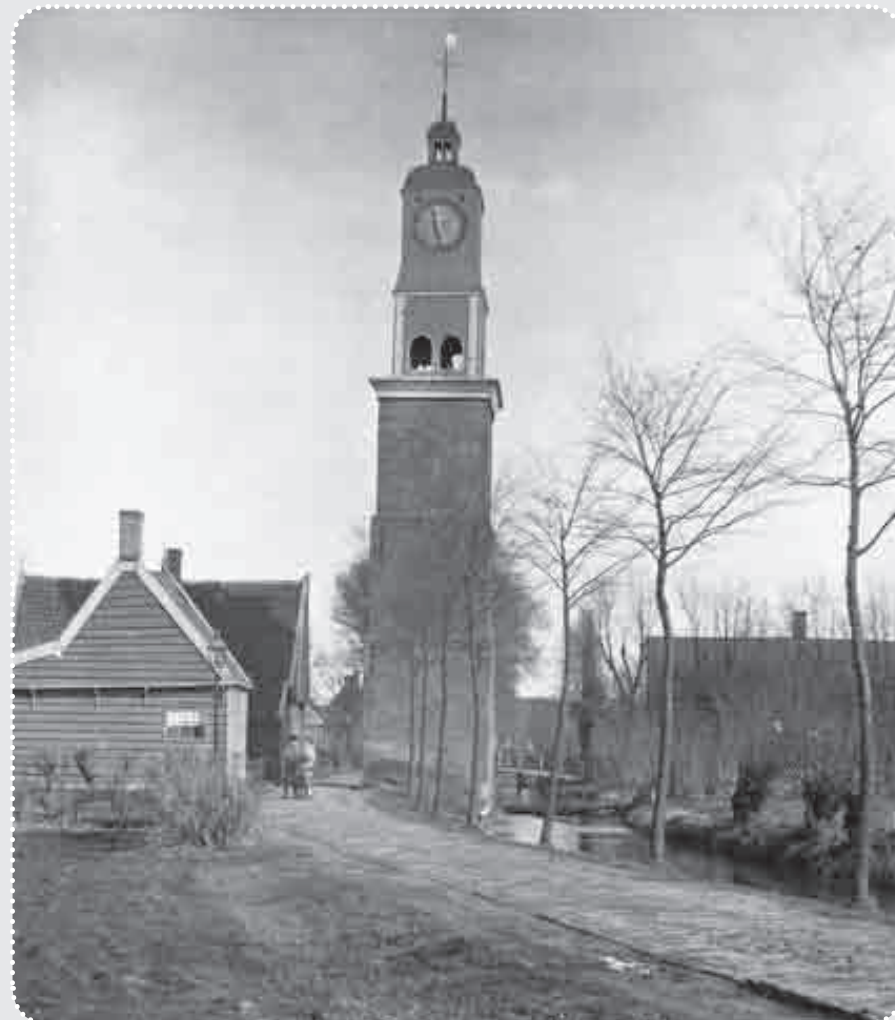
De Beschuitstoren in Wormer omstreeks 1895. De foto geeft een mooi zicht op de bestrate Dorpsstraat met de ingereden karrensporen. Rechts de wegsloot en de vele bruggetjes. Foto Oudheidkundige Commissie Jisp, Collectie Wildschut.
