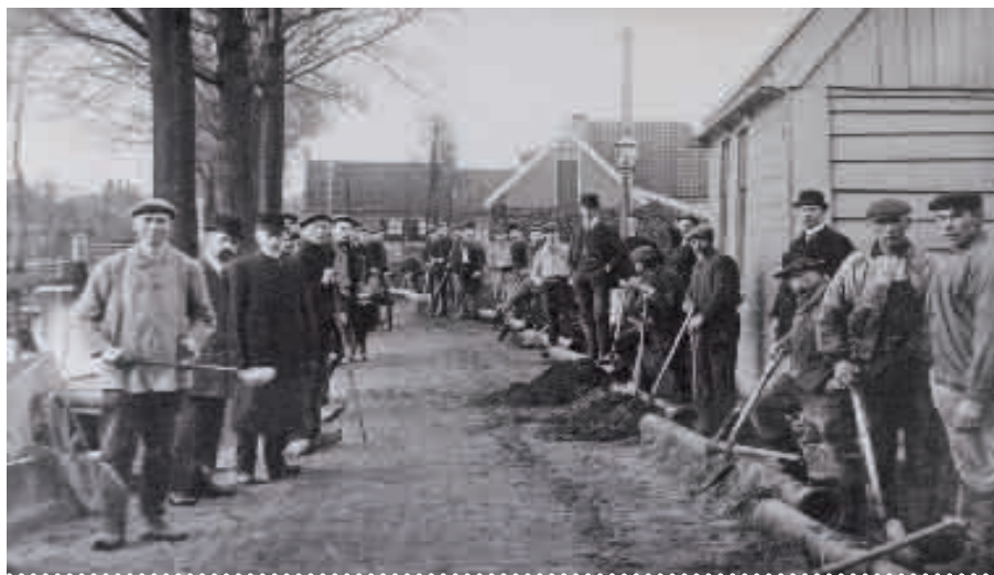
De aanleg van de gasleiding in 1912. Het is duidelijk mannenwerk: er staan alleen maar mannen, allemaal met hoofddeksel, op de foto. Op de achtergrond de oude bakkerij van Kaskes. [Waterlands Archief, Purmerend, beeldbanknr. WAT001006028]
